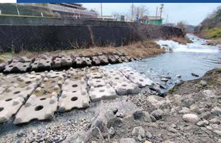
CP コンクリート根固めブロック
